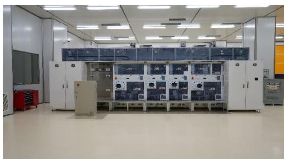
（B200 槽式设备实物图）
